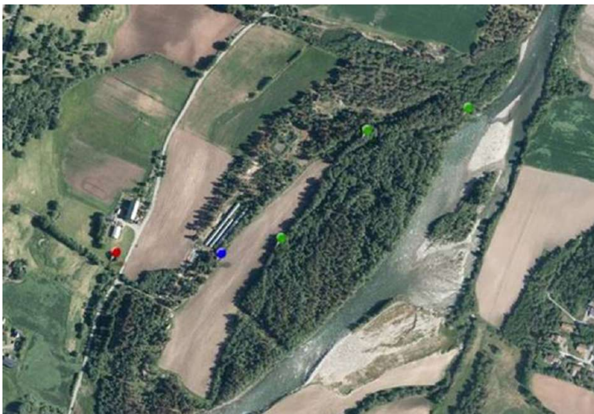
Figur 22. Flyfoto fra 2014 viser dagens situasjon. Rødmkering indikerer ca. vandringsbarriere, blå markering der den krysser under jordet og grønn markering der den i dag fremstår som svært stilleflytende. Foto: www.finn.no .
