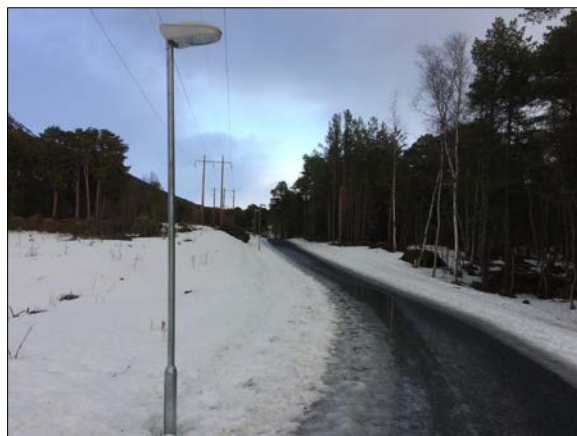
Belysning langs gangvegen ved grusbanen. Foto: Plankontoret
