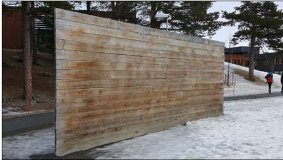
Ballvegg ved Oppdal ungdomsskole mellom gangveg og grusbane. Foto: Plankontoret
