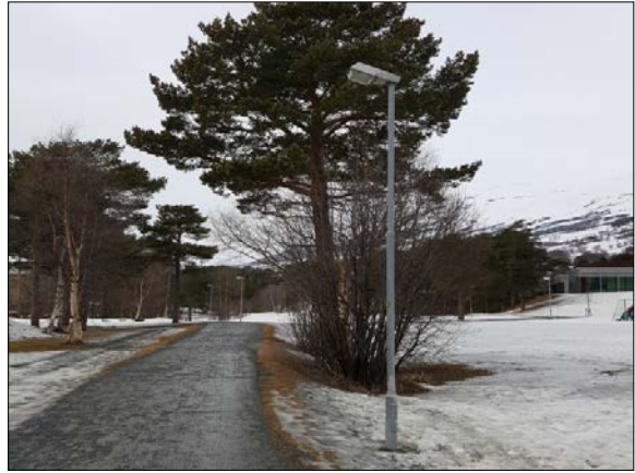
Bildet viser belsning langs gangvegen mellom parkeringen ved ODMS og ungdomsskolen. Foto: Plankontoret
