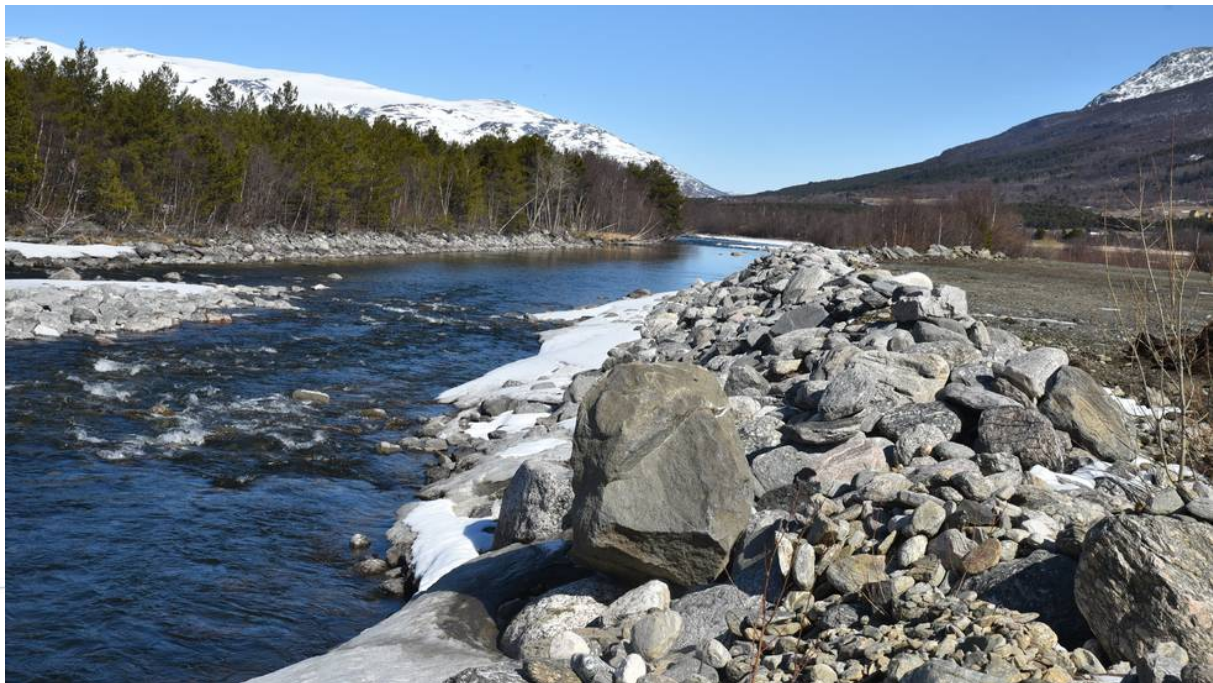
Flomsikring av potetåkre langs Driva. Foto: OPP.no
