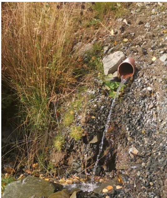
Figur 6: Rennende vann ut av en Ø110 drenering. Ifølge grunneier kommer vannet mest sannsynlig fra kumdren eller dren ved grøftepropp tilhørende VA-anlegget. Det er mulig at en del av vannet i de to flombekkene som forsvinner i grunnen, dukker opp her igjen.
