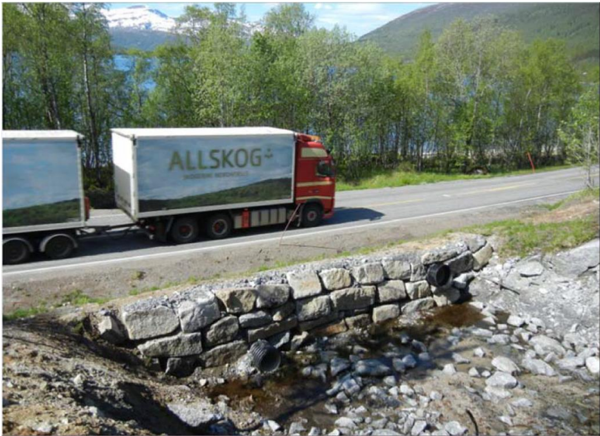
Figur 13: Eksempel på masseavlagringsbasseng som sikring mot sørpeskred. Tørrmuren nærmest vegen i bildet fungerer som bakvegg.
