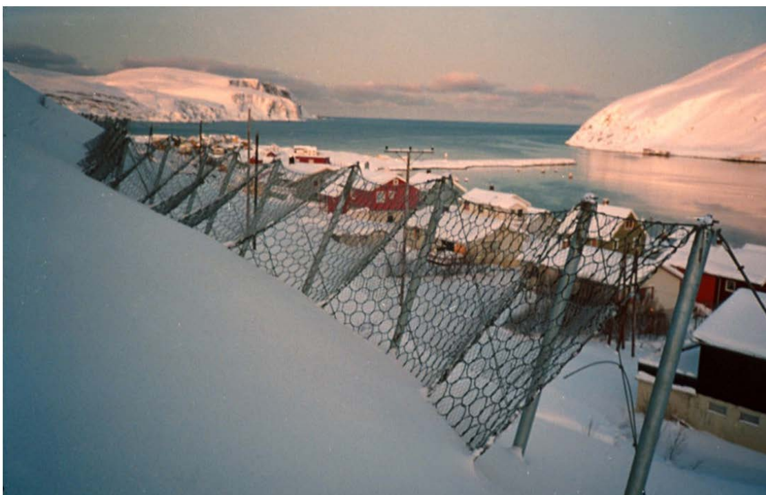
Figur 4 Eksempel på nettforbbygning fra Honningsvåg.
