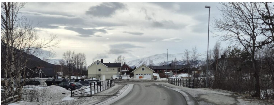
Figur 6: Inge Krokanns veg sett mot sør. I bildet ser vi brua som fører Inge Krokanns veg over Alma, og vegen videre fram mot Vikavegen.
