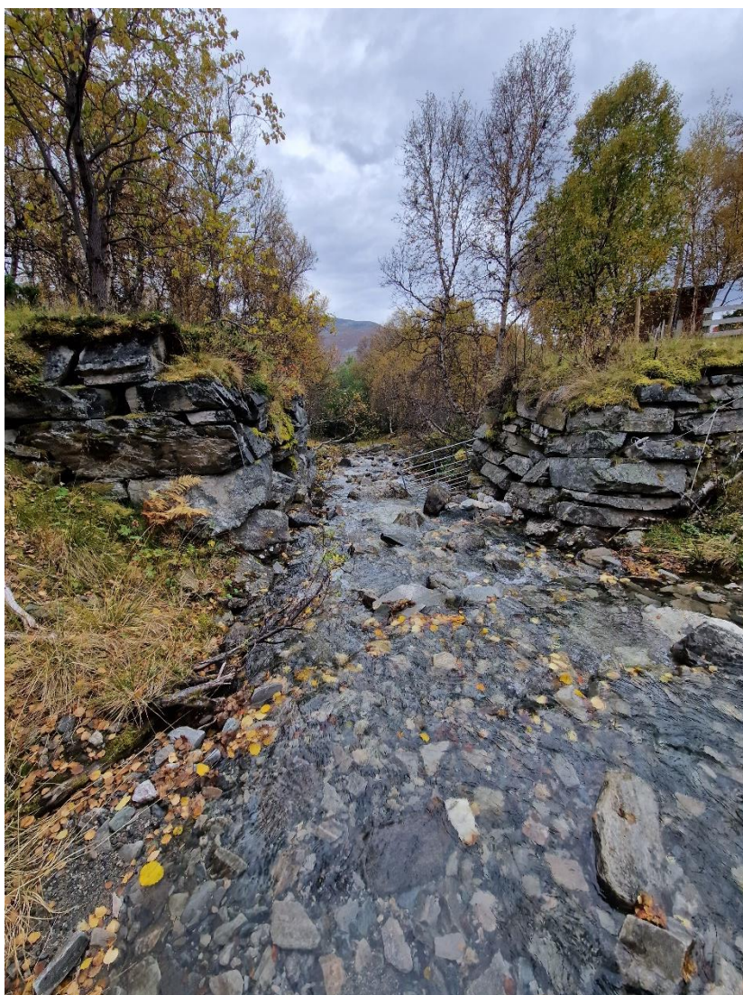
Figur 11 Restane av brua over Håmmårbekken
