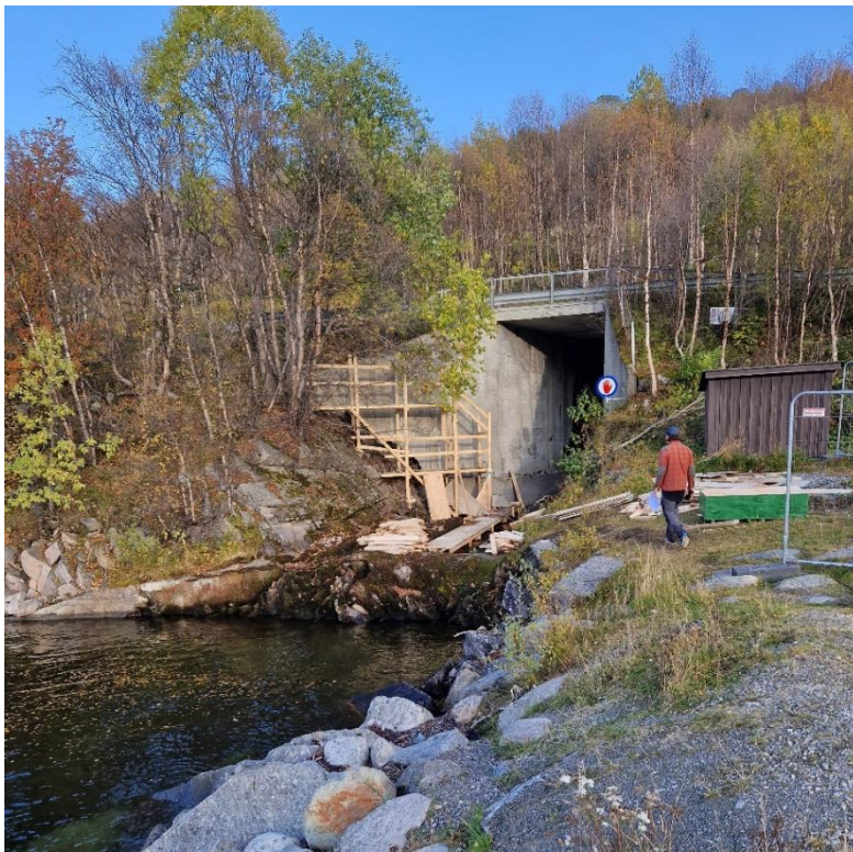
Figur 25 Utløp av overføringstunnel ved Osen
