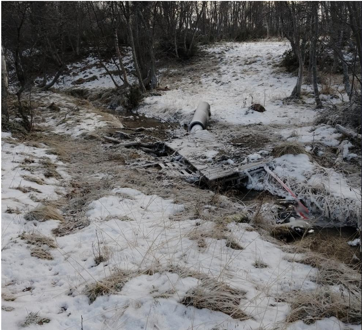
Figur 13: Krysningspunkt ved foreslått trasé (sett fra nedstrøms/vestre side). Det anbefales å flytte krysningspunktet til en klopp lenger oppstrøms hvor bekkeløpet er bedre definert. Bekkeløpet er synlig mer definert oppstrøms dagens krysningspunkt.
