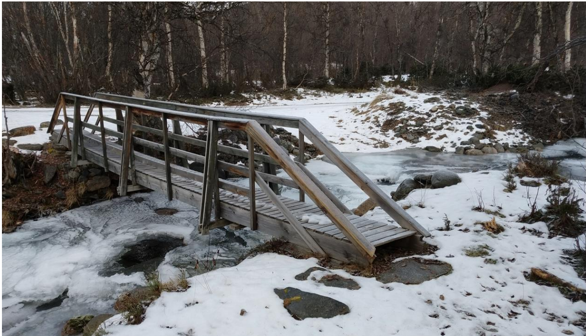
Figur 8: Nedre krysningspunkt over Grøtbekken. Eksisterende gangbru med vadested i bakgrunnen.
